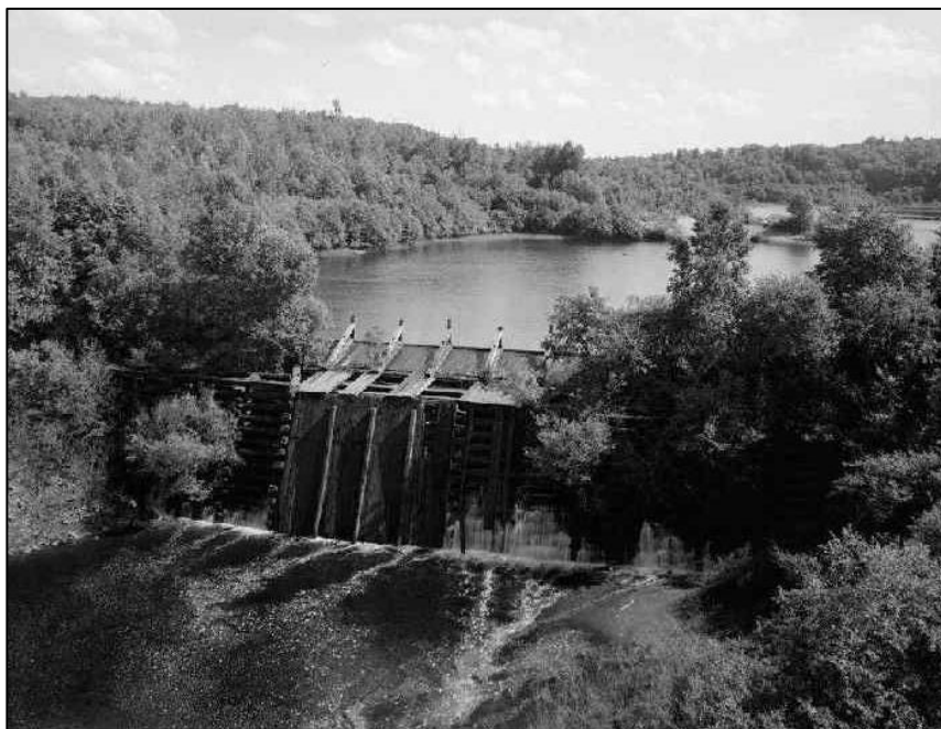
Figura 1-12 Një digë me armaturë druri në Michigan, fotografuar në 1978 (Lowe, 1978)
