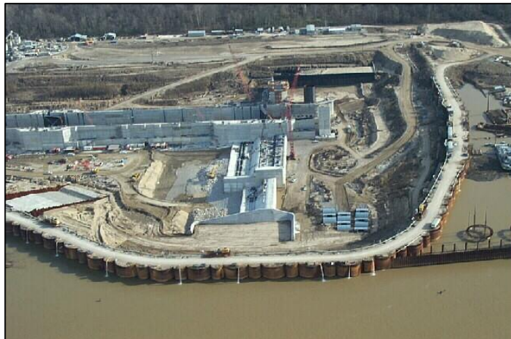
Figura 1-18 Model i digës Cofferdam gjatë rikonstruksionit (Diga Montgomery Point Lock and Dam, USA) (U.S. Army, 2010)
