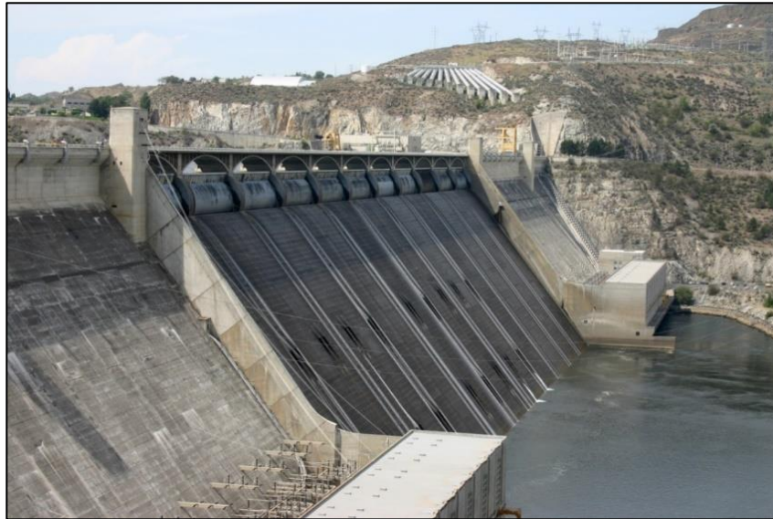
Figura 1-3 Grand Coulee Dam është shembull i një dige solide graviteti (Duck, 2011)
