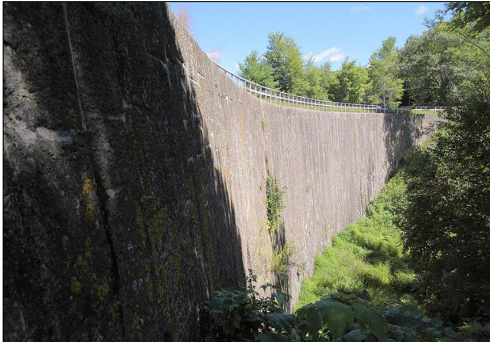
Figura 1-5 Diga Jones Falla, në Kanasa, është dige më rreze konstante (Nazarenko, 2009)
